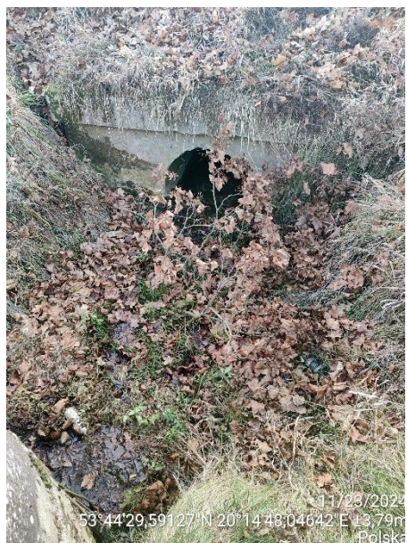
zdj. 7 przepust drogowy pod drogą DP1370N
